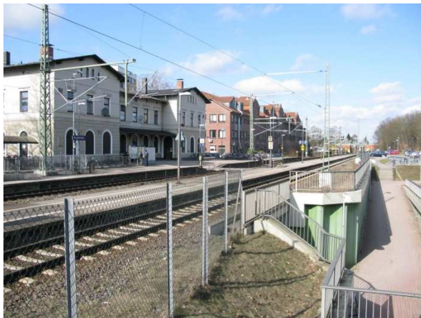
Dworzec: przejście podziemne bez wejścia na peron
